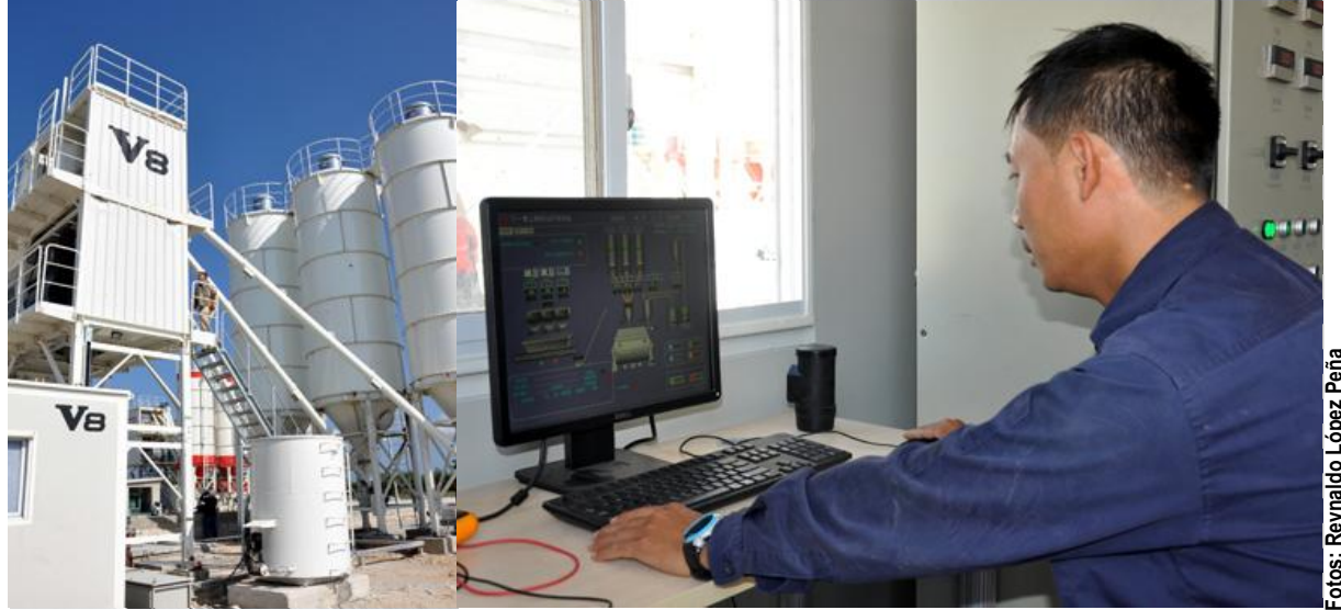
El suministrador de la planta de hormigón instalada fue el Grupo SANY. Su marca es la número uno en China y una de las líderes a nivel mundial en maquinarias de bombeo de hormigón.
