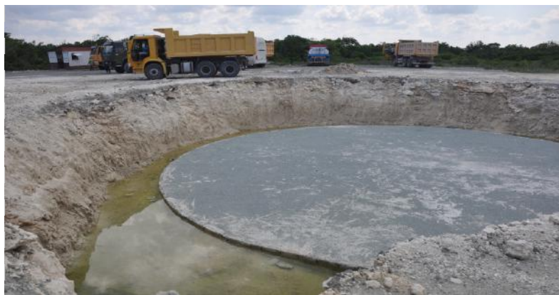
Se trabaja al unísono en ambos parques en la perforación y voladura de las bases, así como en el hormigonado de los sellos de nivelación.
