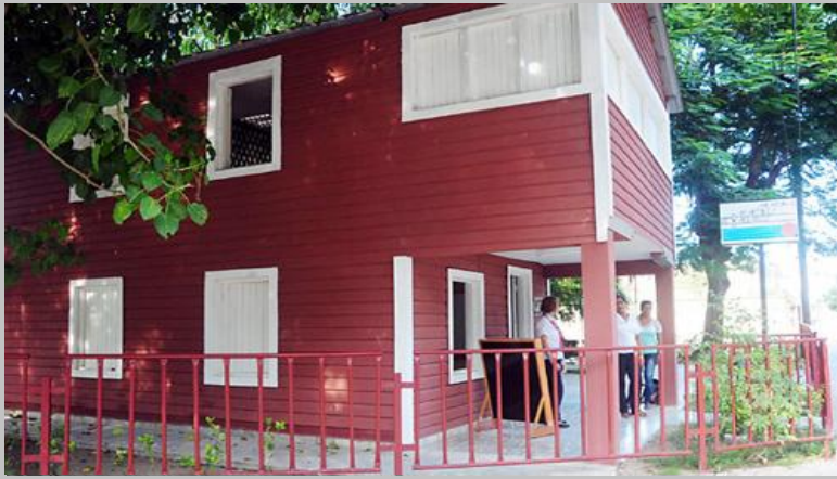
La rehabilitación con mampostería semeja la madera original utilizada en las paredes.
