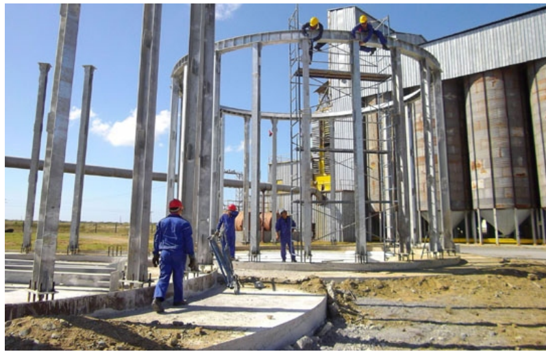
A buen ritmo marcha el montaje de los nuevos silos.
