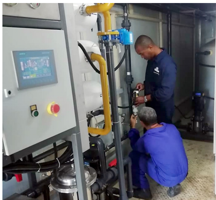
Foto: Cortesía de la Empresa de Acueducto y Alcantarillado
