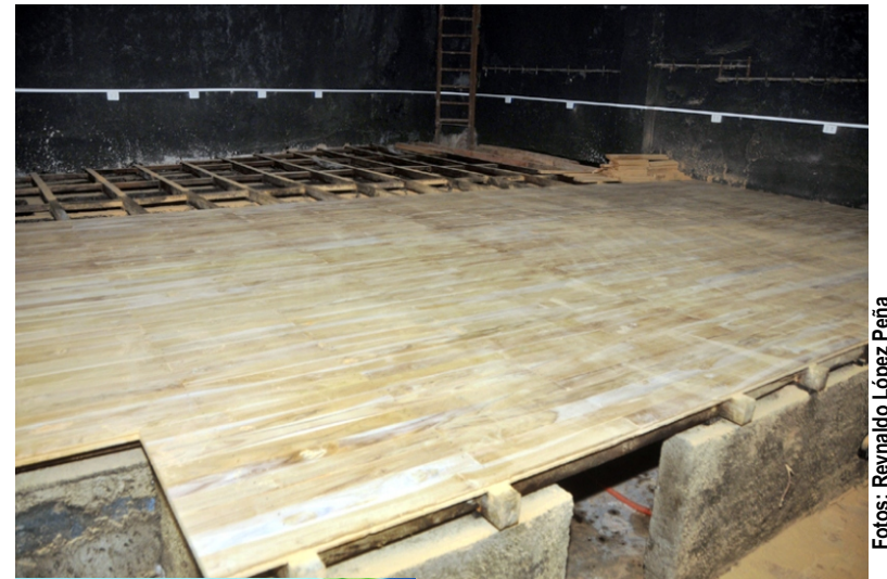
Las labores en la "Raúl Gómez García" se han concentrado fundamentalmente en el área del tabloncillo.
